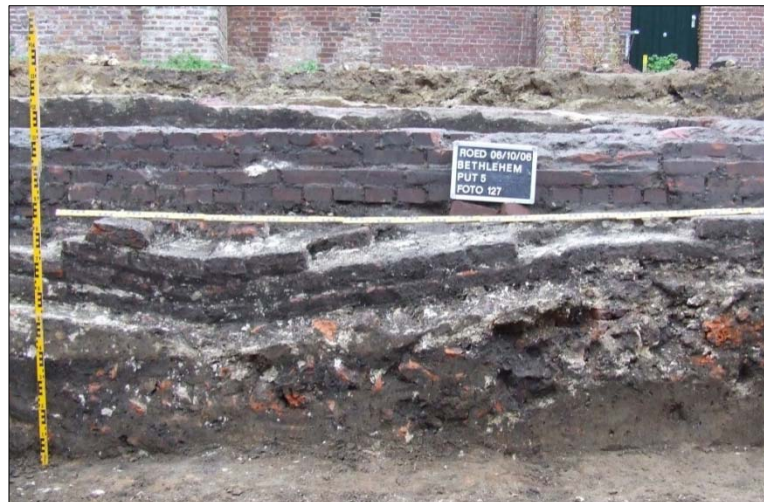
Afbeelding 97. Zijaanzicht Tuinmuur 1 ter hoogte van Kluis 2, gefundeerd op puin. Verzakking ter hoogte van Afvalkuil 2.
