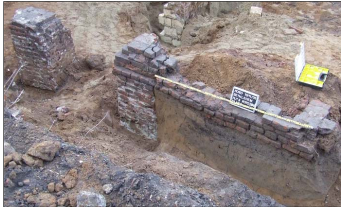
Afbeelding 31. Poer 10 en 19. Duidelijk te zien is dat deze overbouwd werden door een muur die tevens Kuil 114 snijdt.
