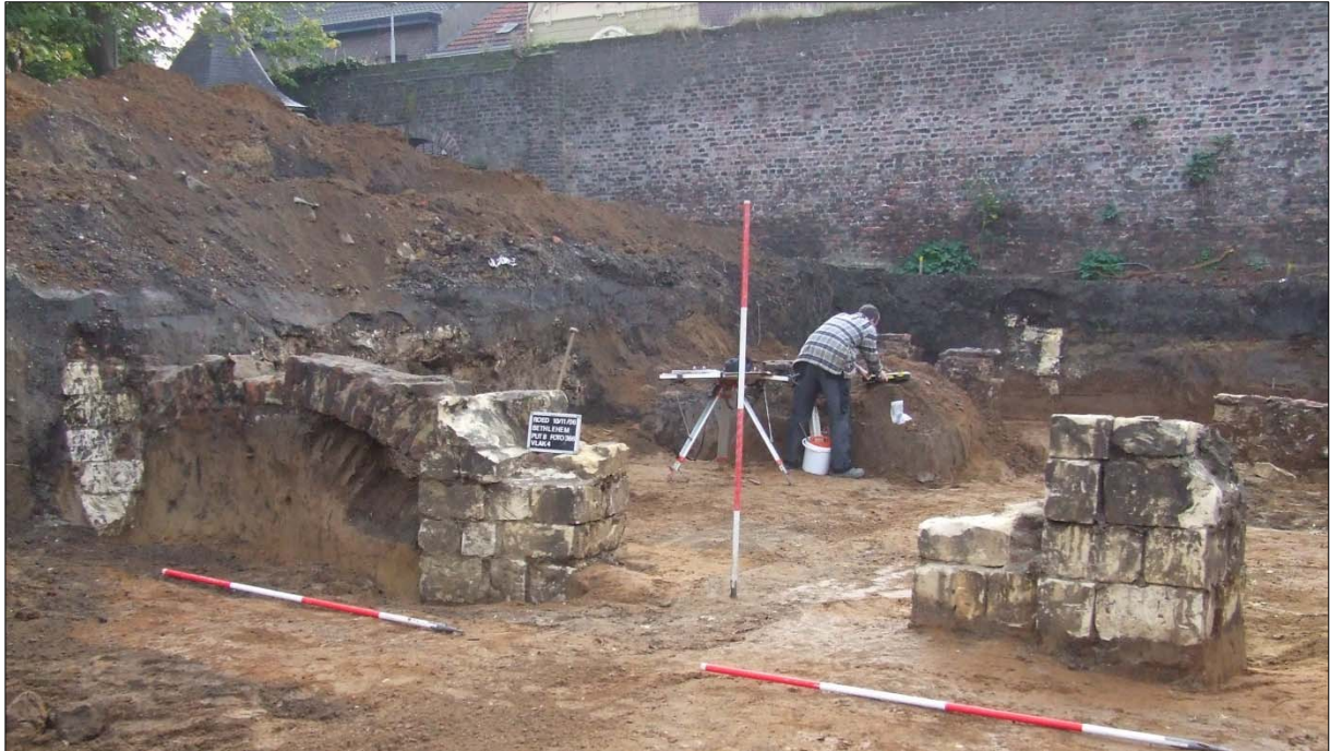
Afbeelding 122. Restanten van Tuinmuur 3 in Werkput 8. Op de achtergrond is de huidige kloostertuinmuur langs de Voogdijstraat zichtbaar.
