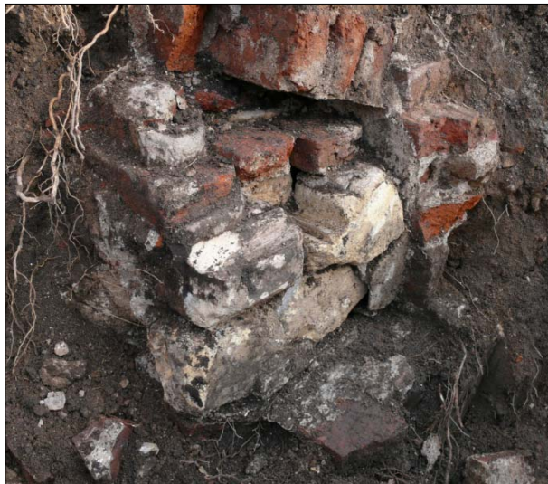
Afbeelding 102. Kelder 7 behorende tot Kluis 3, dichtgezet tijdens Bouwfase 2 met sloopafval. Let op de mergel ornamenten.
