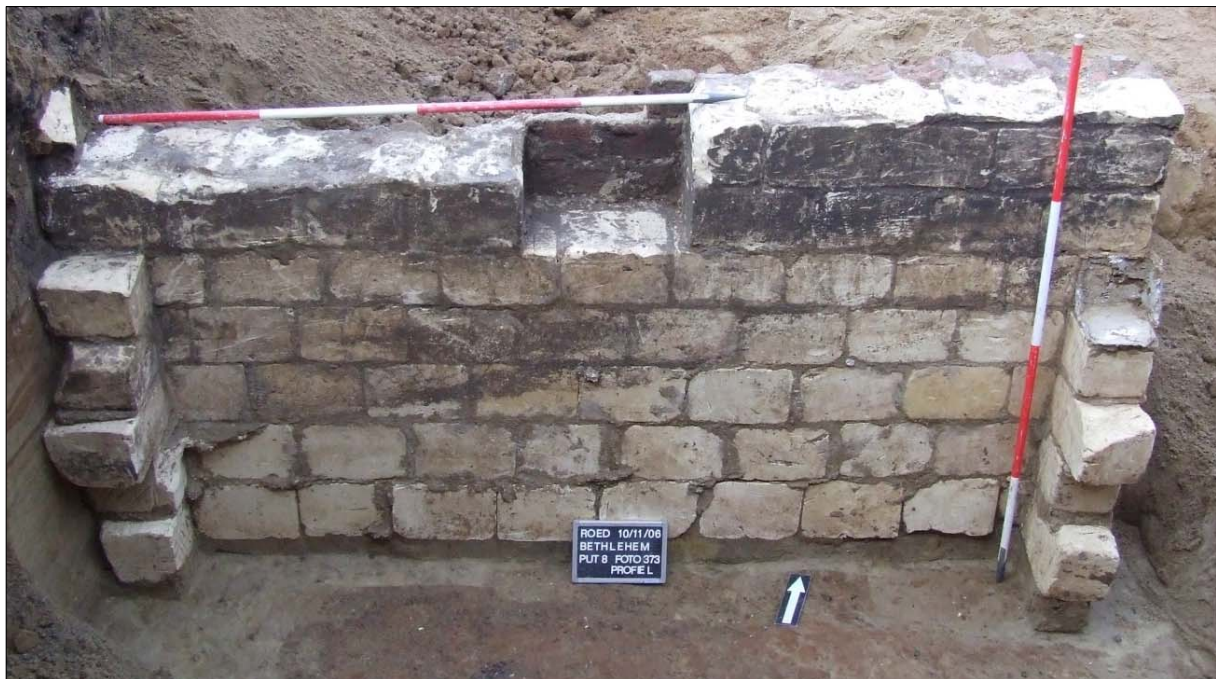
Afbeelding 39. Zuidelijke zijde van de onafgewerkte Keldermuur 100. Op de vertandingen waren metsersmerken zichtbaar.
